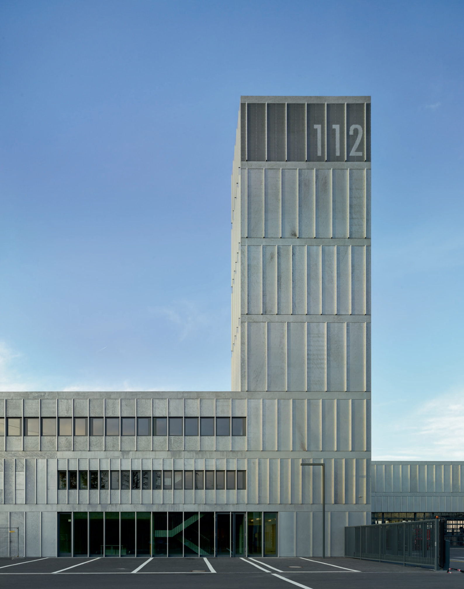
Ehemals Aussichtsturm und Trockenraum für benutzte Schläuche: die altbekannte Vertikale findet sich auch beim Feuerwehrzentrum Köln-Kalk wieder.
