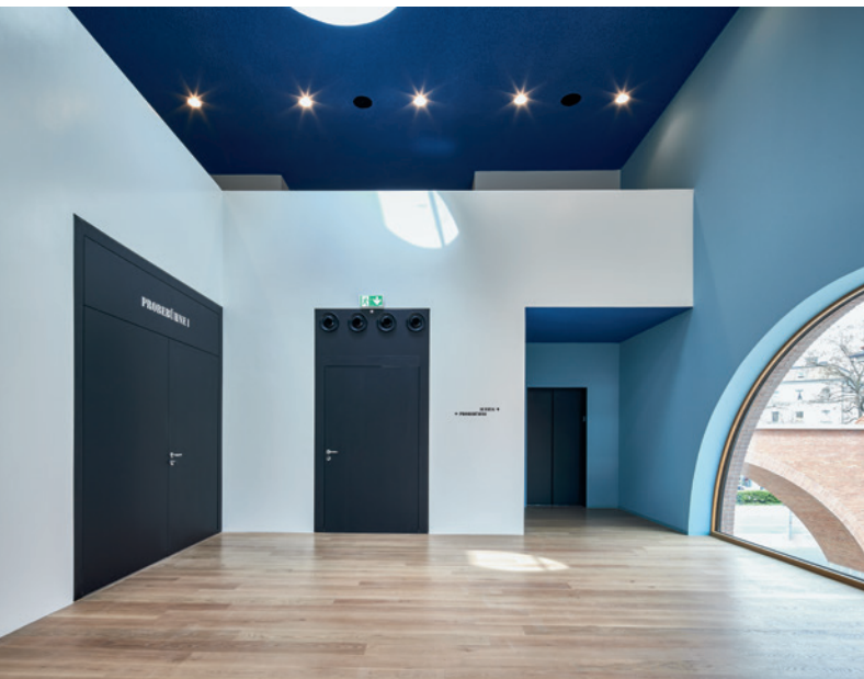
Lüftungsauslässe sind gestalterisch in die Oberblende integriert.
