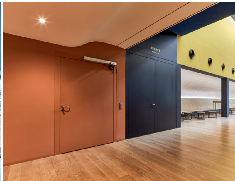
Einige Türen mit ungewöhnlicher Breite haben eine automatische Schließanlage.
