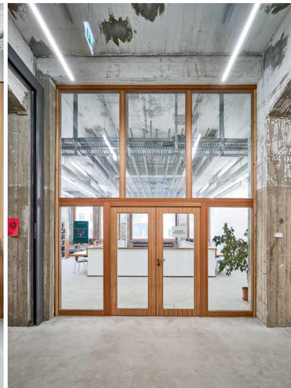
Typisches Anwendungsbeispiel für Schörghuber Festverglasungen: der transparente Besprechungsraum. Hochschalldämmende Festverglasung.
