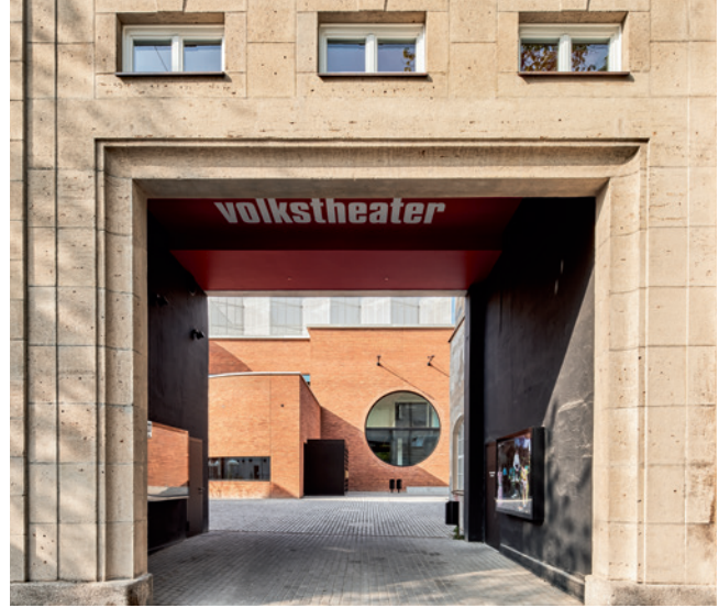
Einblick: Ein Zugang zum Innenhof führt durch den Bestand.
