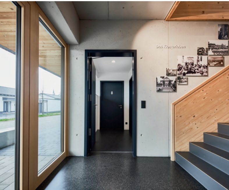
Die Türblätter zum Sanitärbereich sind mit einer ABS-Kante ausgestattet.
