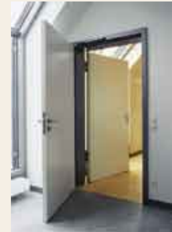
Podwójne drzwi łączą funkcję przeciwpożarową z dźwiękoszczelną (Rw, P = 52 dB).
