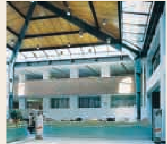
Blick in die angenehm helle Schalterhalle.
