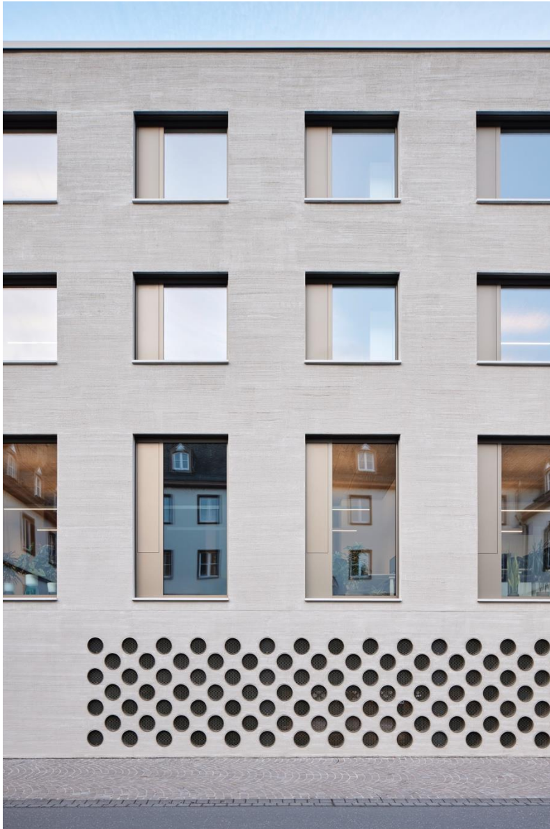
Bild 4: Ungewöhnlich: Der Sockel dient dem Hochwasserschutz.
