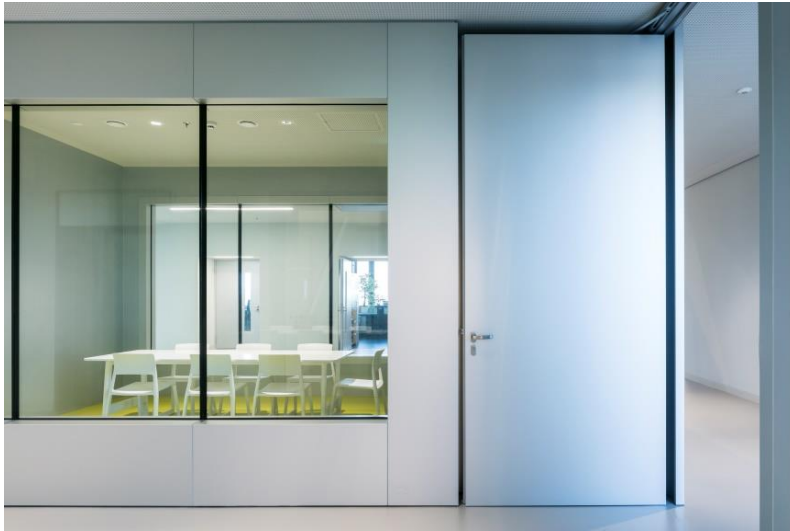
Bild 3: Geöffnete Niscentüren lassen sich optisch unauffällig in die Wand integrieren.
